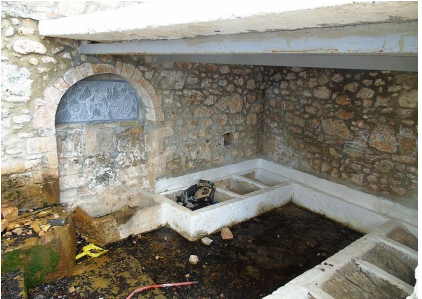
Altes Waschhaus auf dem kurzen Weg zur Kirche
