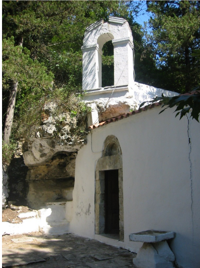
[3] Die Kapelle „Pente Parthenes“ zu Lappa ist in den Felsen vor die große Grotte gebaut
